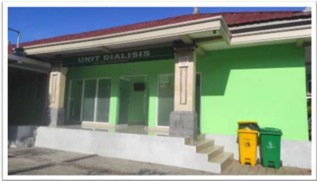
Gambar 26. Pembangunan Unit Dialisis
